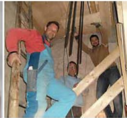
Einbau der Gegengewichte für die Turmuhr aus dem Hause Rauscher Regensburg, Baujahr 1927 (Matthias Obermeier)
