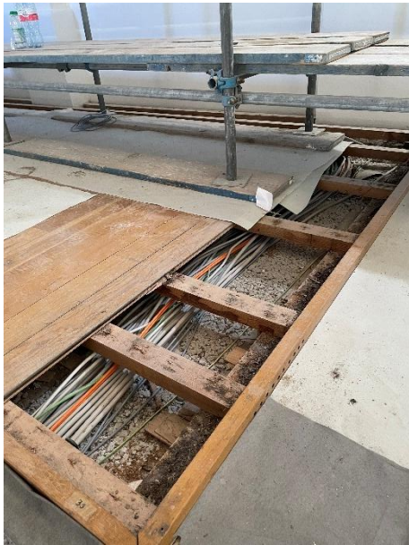
Die Kabel sind verlegt
